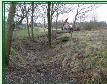
Zanesené původní koryto Řepského potoka
