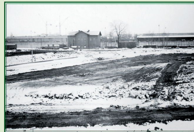
Místo, kde stávala řepská lípa, v pozadí budova nádraží (1982)
