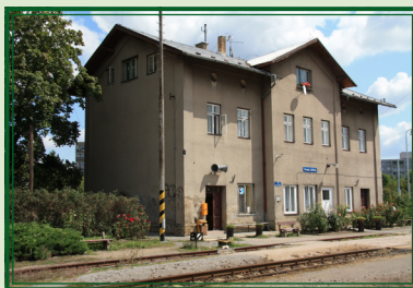
Budova nádraží dnes (2013)
