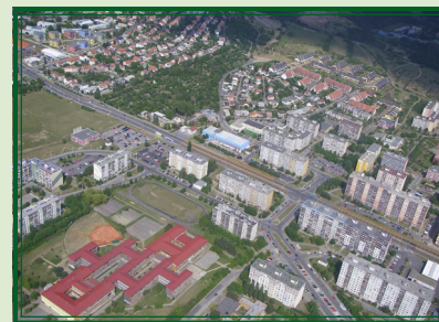
Slánská, Žufanova, Bazovského a okolí, uprostřed budova polikliniky, vlevo nahoře křižovatka Slánské a Čistovické, vlevo dole areál ZŠ Jana Wericha (2007)
