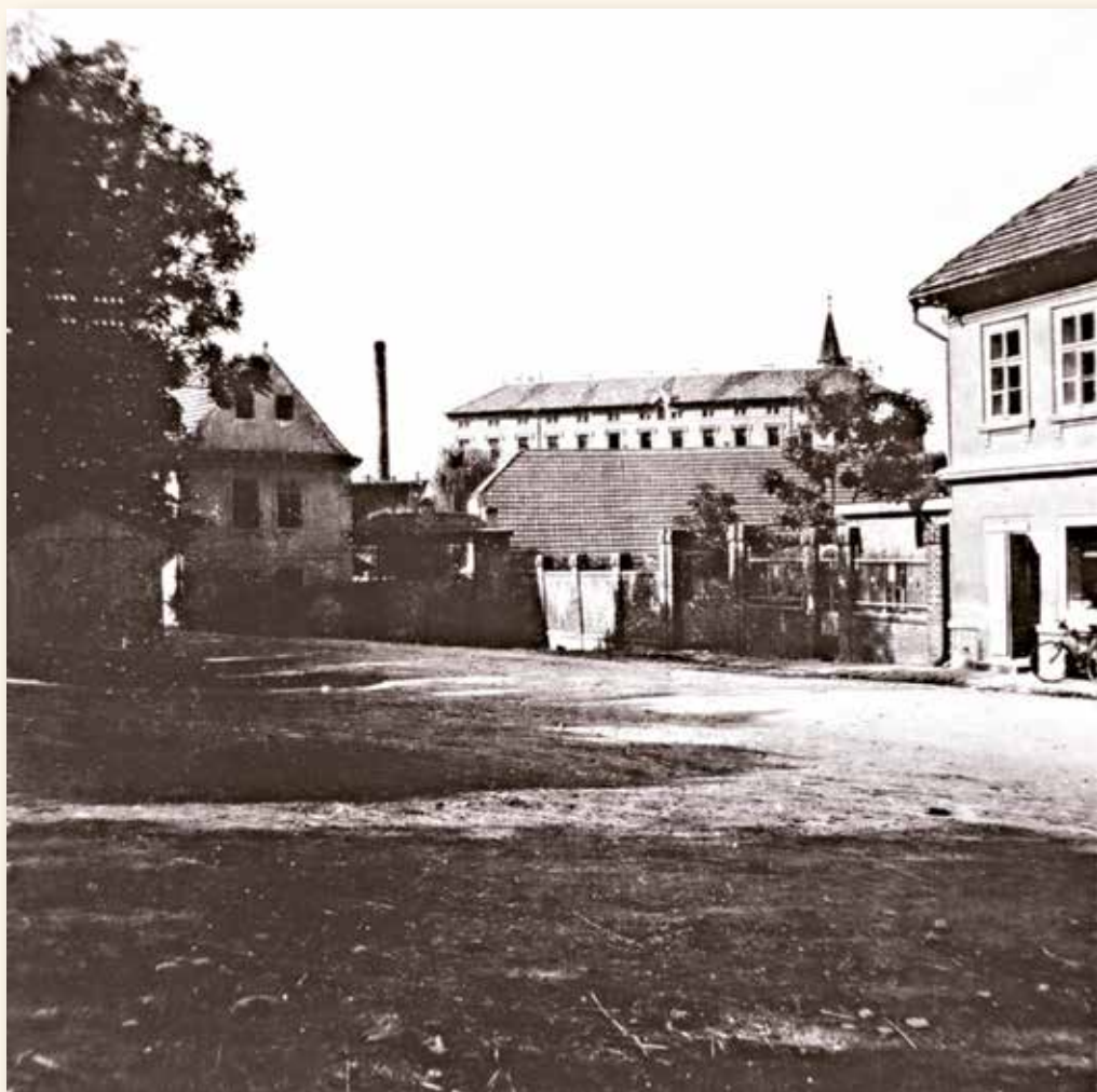
Klášterní statek v pozadí s budovou kláštera (věznice) na dnešní ulici Žalanského vedle původní hasičárny, na snímku z roku 1943. V pravém okénku úplně dole vedle vrat dožil poslední šafář klášterního statku pantáta Spálenka.
