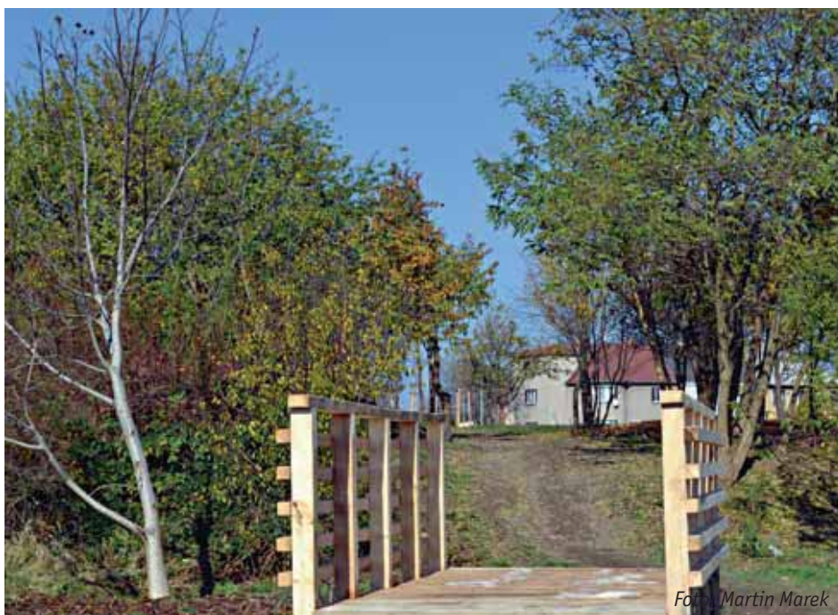
Novou lávkou v horní části pláňe na Fialce (vedle bikrosového areálu) oceníme zvláště v době deštivého počasí.
