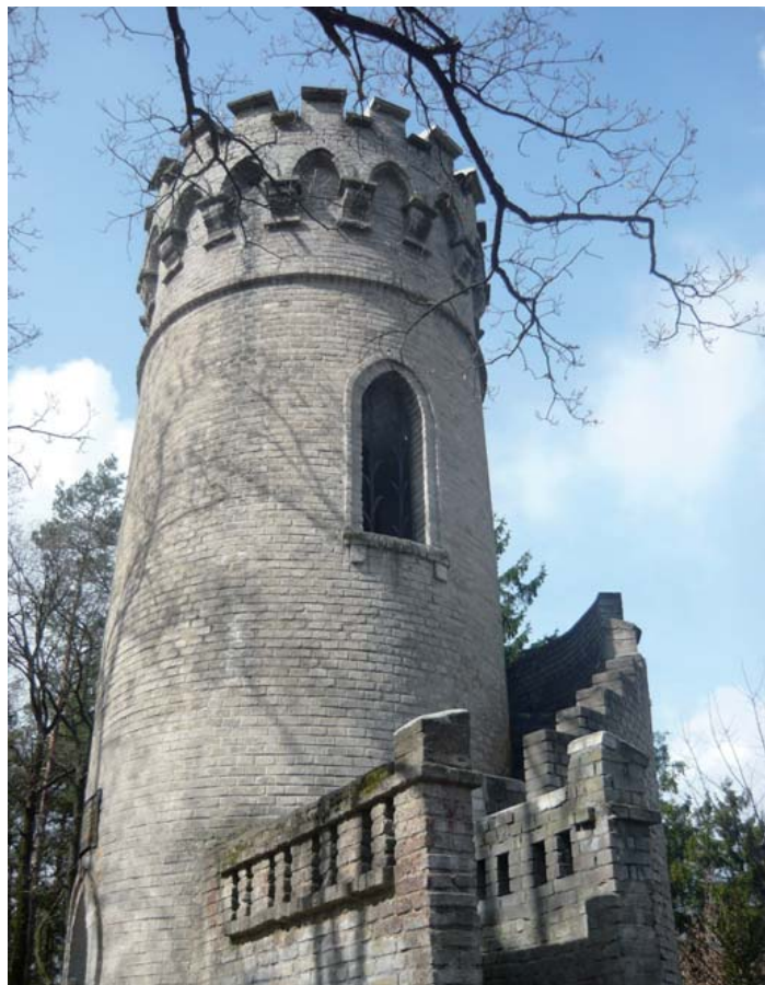
Na vyhlídkovou terasu rozhledny Děd nás dovede 56 schodů.
