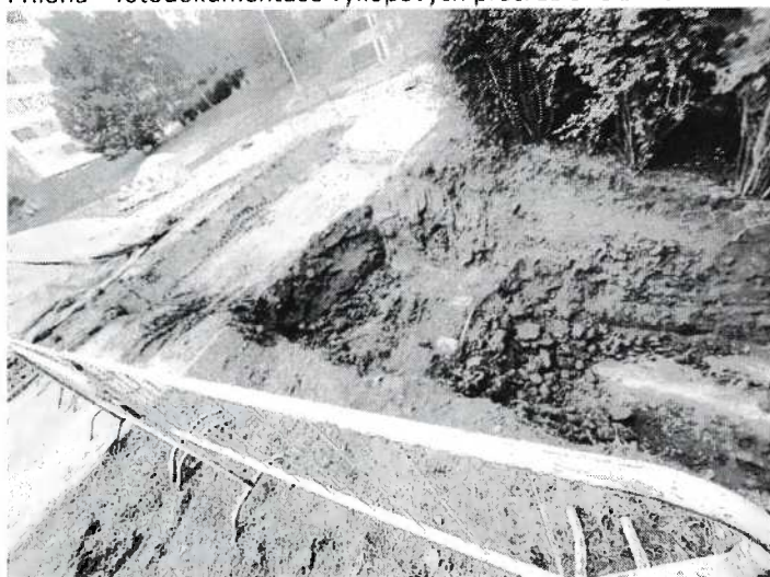
Příloha – fotodokumentace výkopových prací za dne 31. 8. 2022
