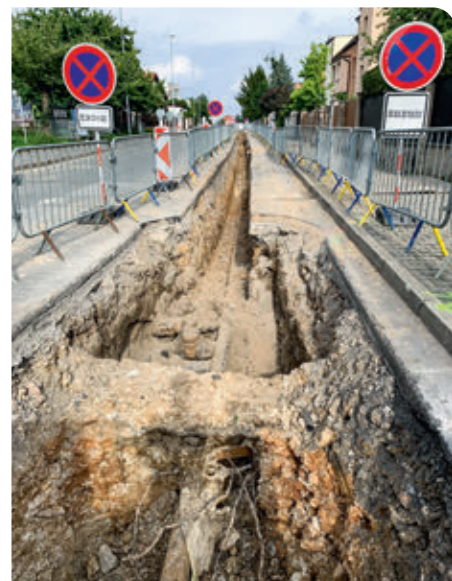
Rekonstrukce plynovodu v ulici Čistovická proběhla na podzim loňského roku.
