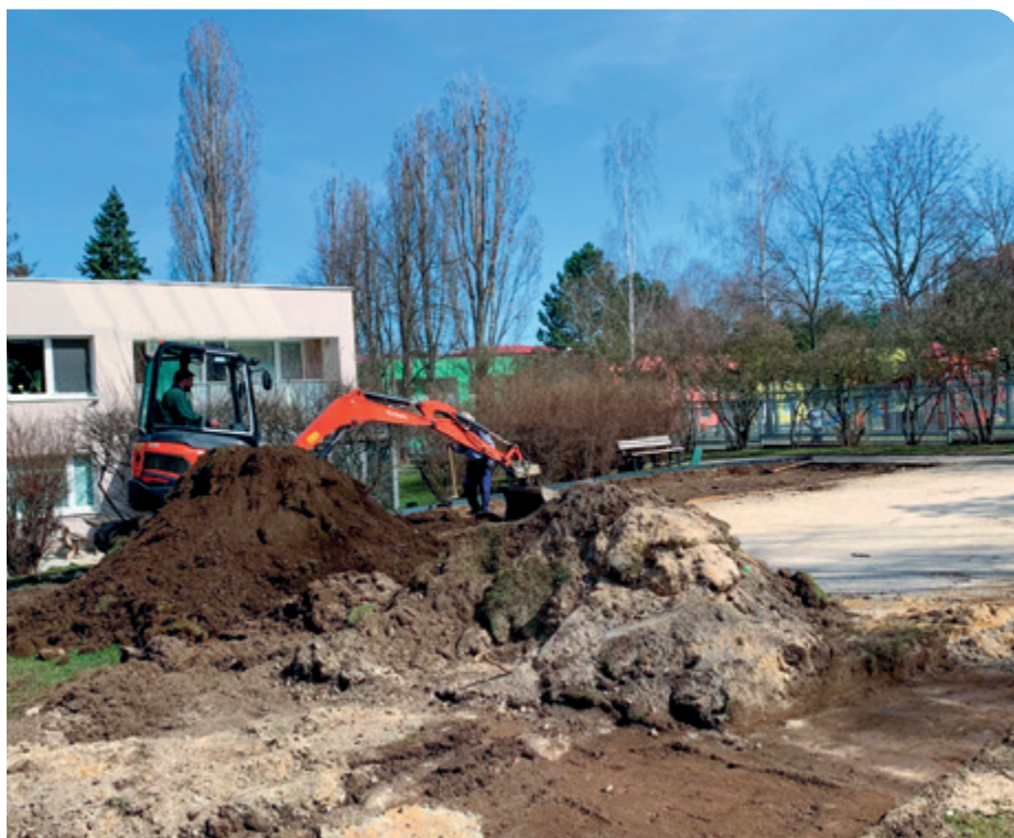
Stavební práce na zvětšení hřiště pro pétanque na 13 x 18 metrů. Foto: Jiří Holub
