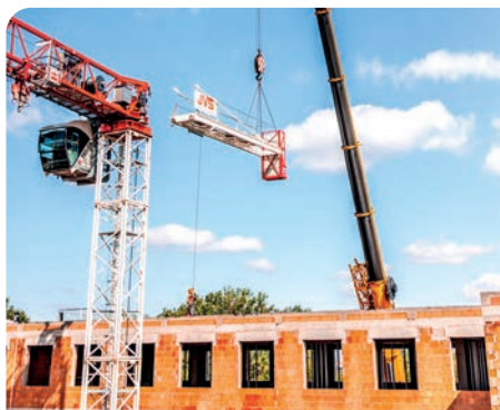
Na konci července proběhla na stavbě demontáž jeřábu, který byl umístěn uprostřed nádvoří.
