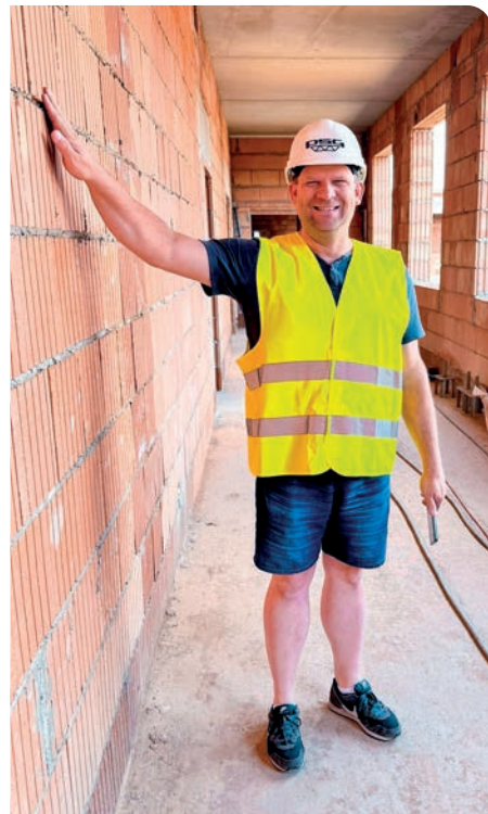
Stanislav Hruška na kontrolním dnu stavby řepského Domu s pečovatelskou službou. 2x foto: archiv CSZS
