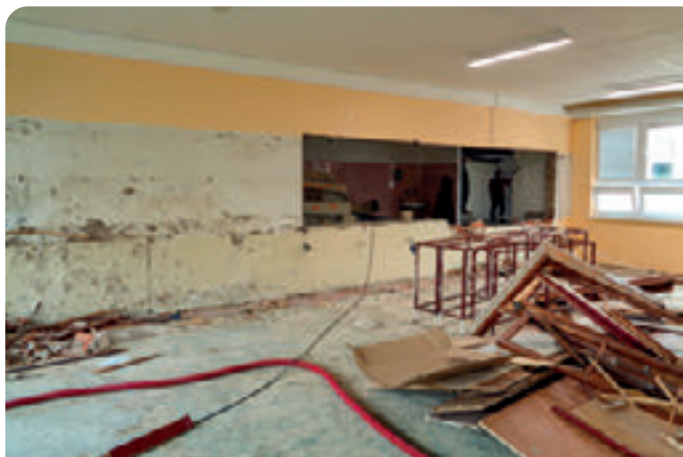
Červenec - zahájení rekonstrukce.
