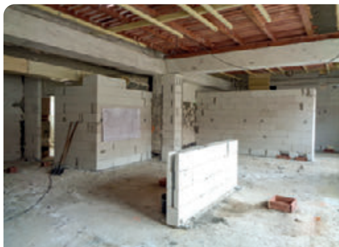
Srpen - pokračování stavebních prací.
