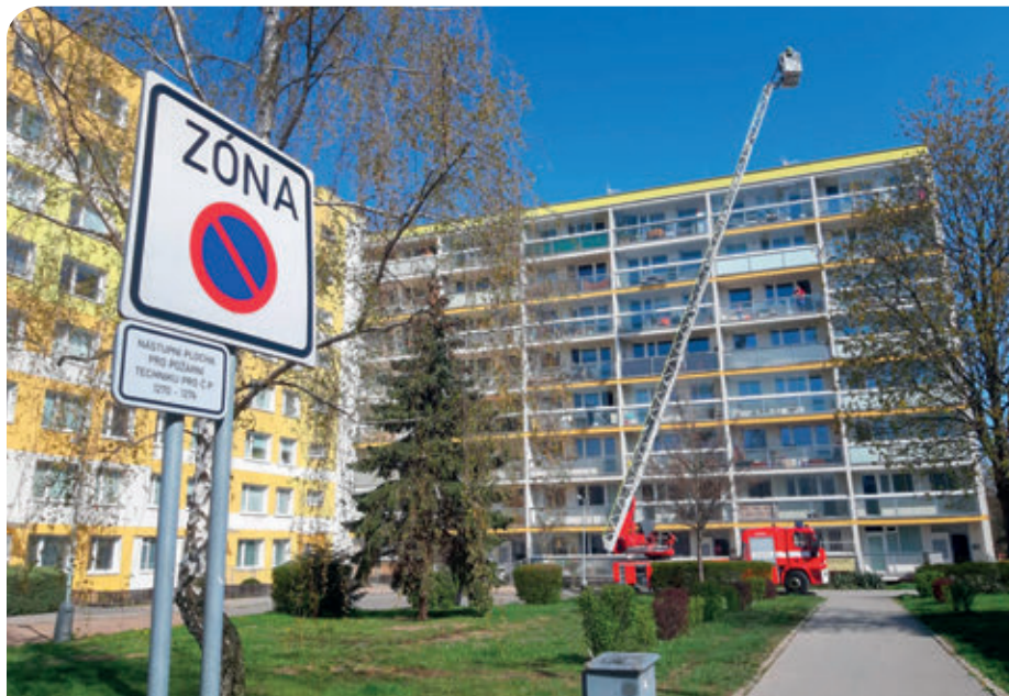
Obnovené dopravní značení nástupní plochy pro požární techniku v ul. Španielova. Nástupní plocha je tvořena tzv. zálivem a pokračuje pojezdovým chodníkem (asfaltová část + zatravněvací dlažba).
